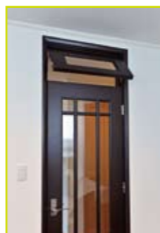
[欄間付きドア] 上部のみ開閉式欄間とすることで無理なく風を通す
