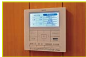
[HEMSとEV] 家全体のエネルギーを見える化するHEMSや（本体はクロークに収納）、電気自動車へ給電するEVコンセントも装備
