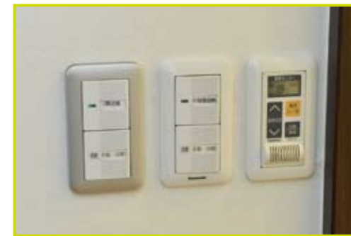
[床・壁・小屋裏の高断熱化] 2階踊り場には、1階や小屋裏の換気扇を集中コントロールする壁スイッチも
