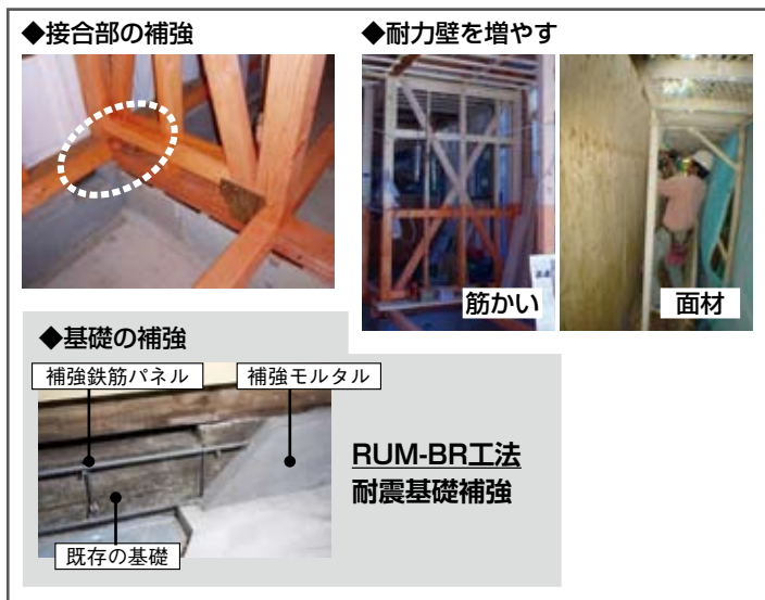
図表3-1 耐震補強の方法
